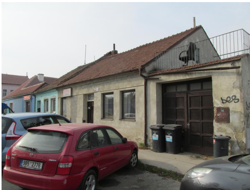
Foto č. 1: Celkový pohled na objekt č. pop. 3255 k.ú. Židenice
