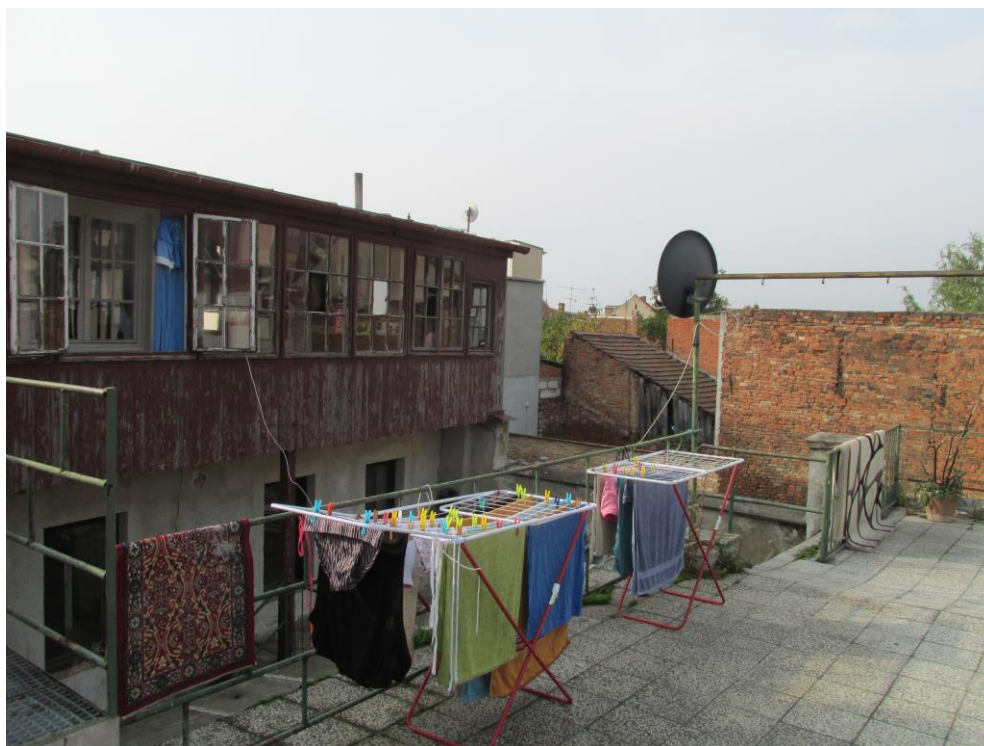
Foto č. 5 : Celkový pohled na objekt č. pop. 3255 k.ú. Židenice - dvorní část
