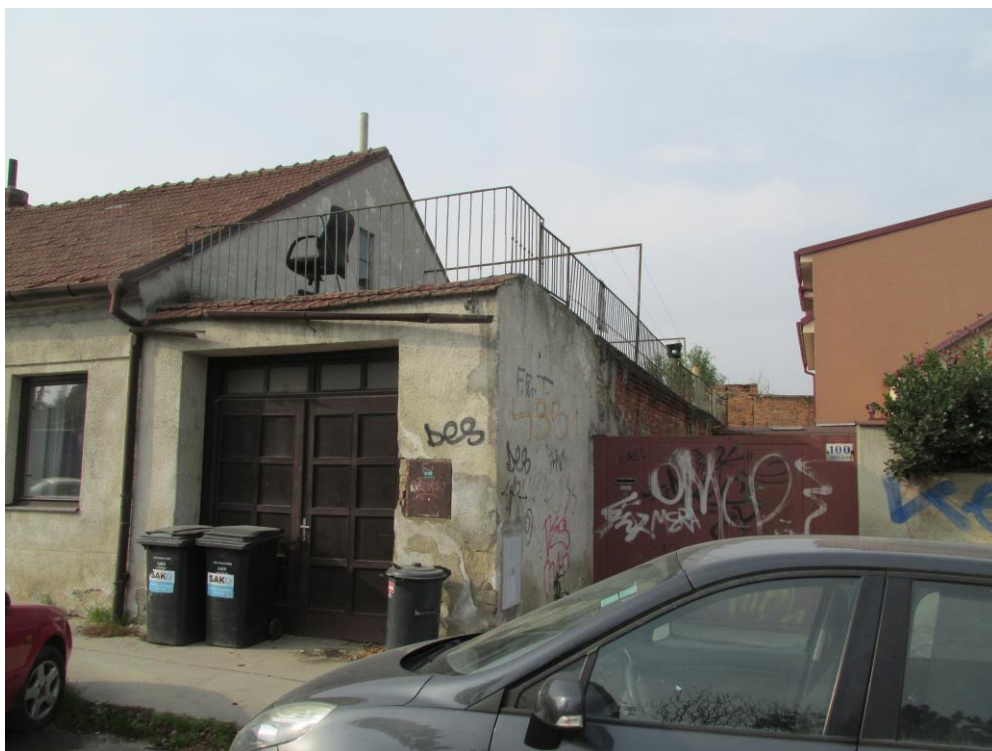
Foto č. 3 : Celkový pohled na objekt č. pop. 3255 k.ú. Židenice
