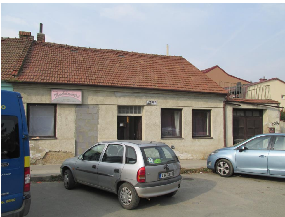
Foto č. 2 : Celkový pohled na objekt č. pop. 3255 k.ú. Židenice
