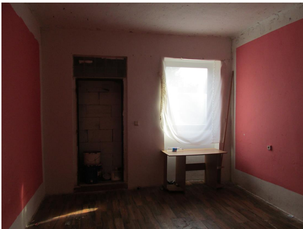
Foto č. 8 : Interiér bytu 1. NP
