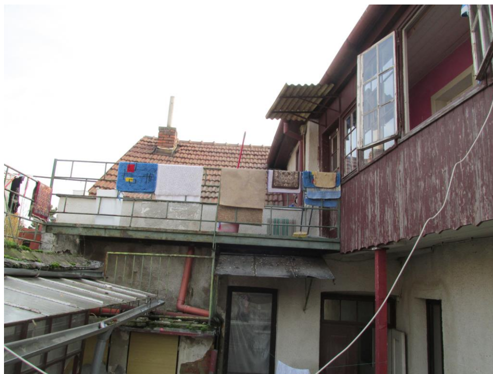
Foto č. 4 : Celkový pohled na objekt č. pop. 3255 k.ú. Židenice – dvorní část
