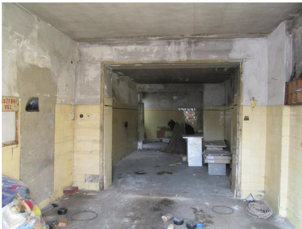
Foto č. 6 : Interiér garáže
